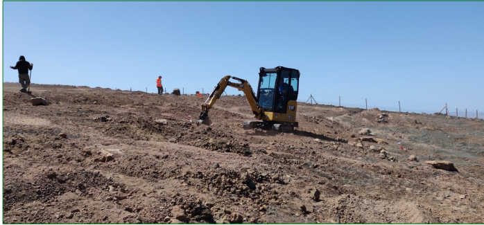
Movimientos de tierra
