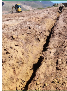
Zanjas de drenaje
